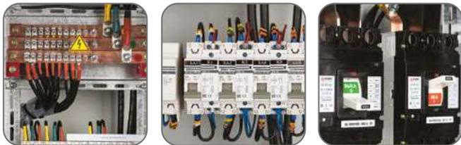
Шкафы серий ВРУ-1М PROxima и ШРС PROxima предназначены для сборки одиночных НКУ, которые не требуется соединять в секцию. Несъемные боковые панели обеспечивают дополнительную жесткость каркаса и большую площадь монтажа, так как элементы креплений расположены на боковых панелях с внутренней стороны шкафа.
