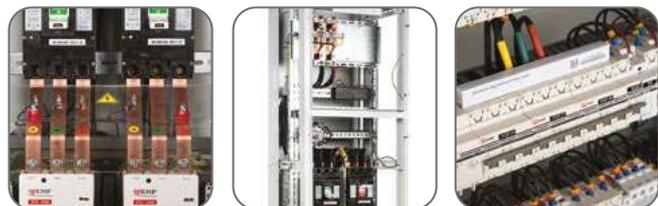
Щиты конструктива ЩО-70 Unit PROxima используются для сборки НКУ, которые устанавливаются в помещения с ограниченным доступом, так как у шкафа отсутствуют крыша, боковые и задняя панели. Также имеется приборная панель, которая позволяет вывести сигнальную арматуру на уровень выше двери.
